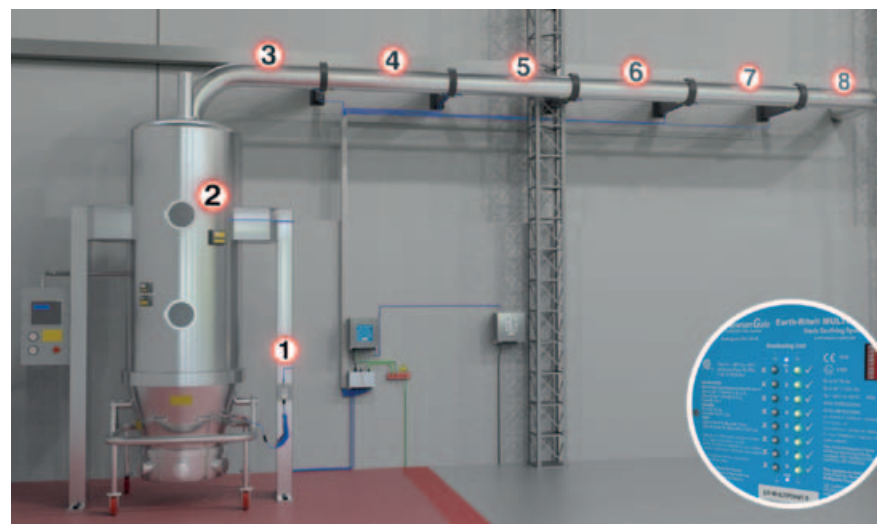
Afb. 2 Earth-Rite Multipoint II toegepast op een transportsysteem, waarbij de onderdelen die elektrisch kunnen worden geïsoleerd (1-8) worden geaard en bewaakt.
